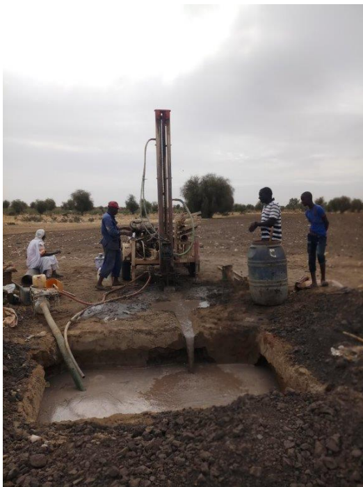
Ce n'est pas la ligne 18, mais il y a quand même du boulot : Mini forage à 53 m de profondeur, eau à 23 m, débit de 15 m 3 /h
