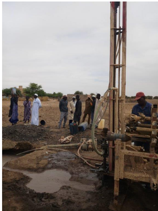
Ce n'est pas la ligne 18, mais il y a quand même du boulot : Mini forage à 53 m de profondeur, eau à 23 m, débit de 15 m 3 /h
