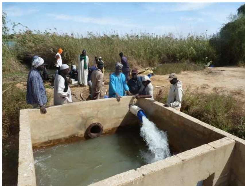
Le fleuve, le GMP, et le bassin de dissipation : l'eau en route pour les cultures
