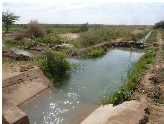
Bassin de dissipation pour maraîchage puis riz d'hivernage
