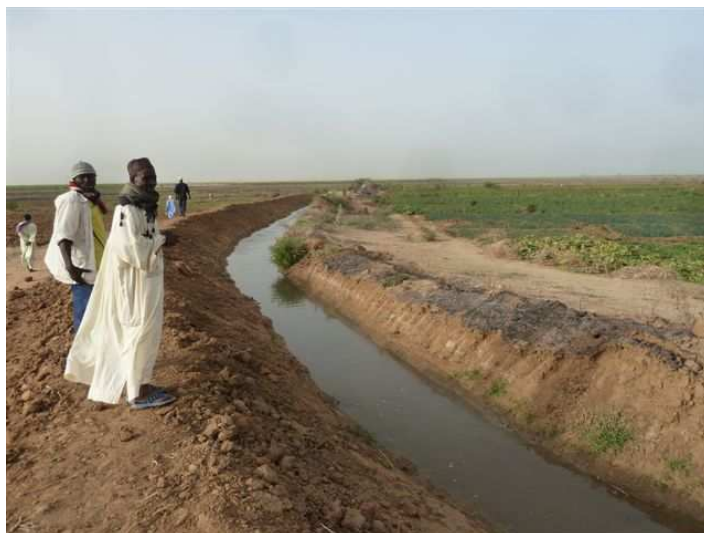
Curage d'un canal permettant l'irrigation gravitaire (sans nécessité de pompe) de 35 ha supplémentaires
